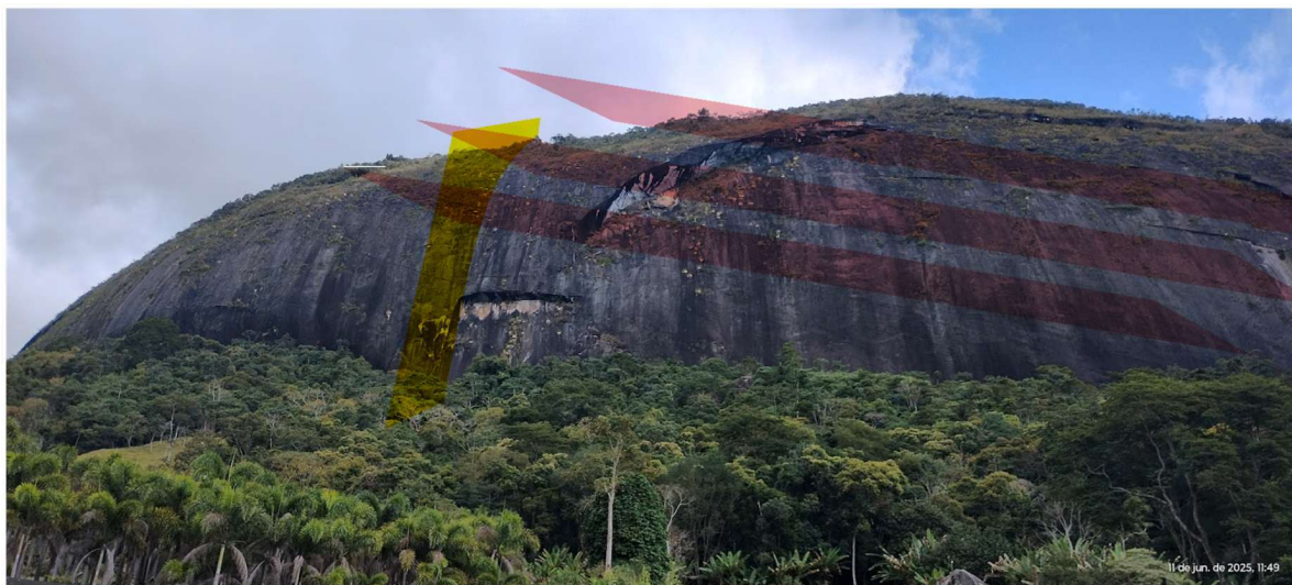
Figura 4 – foto da encosta rochosa alvo da vistoria com a projeção dos planos de foliação (rosa) e projeção do plano de fratura vertical (amarelo).
