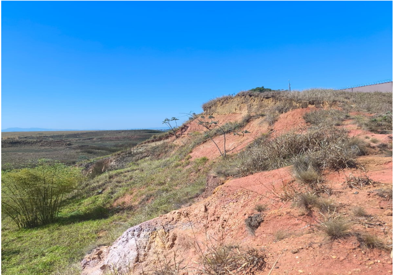
Foto 3: Crista do talude com presença de sulcos e ângulos negativos.
