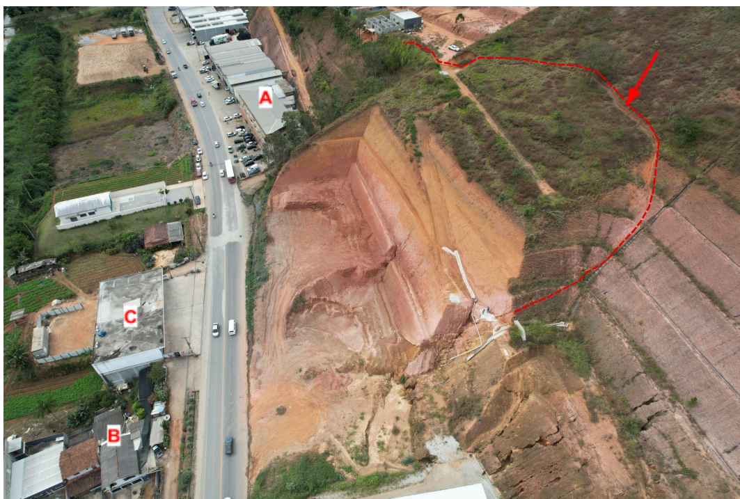
Figura 03: Trinca contínua na porção superior da encosta (seta vermelha) evidenciando a delimitação bem desenvolvida do corpo a ser movimentado; linha delimita seu trajeto. Detalhe para as edificações a jusante na provável projeção do movimento a ser deflagrado: edificação multifamiliar ( A ), edificações unifamiliares ( B ), edificação de uso comercial ( C ), na qual funcionam lojas, um galpão e a Clínica de Avaliação Médico-Psicológica de Condutores de Veículos (Detran).
