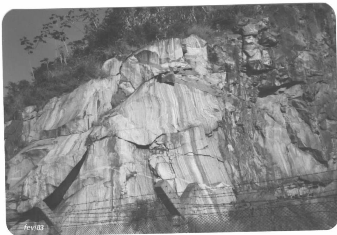
Foto 6 – Migmatito de estrutura notadamente estromático, evidenciando bandeamento persistente centi a decimétrico, caracterizado por faixas máficas (biotita gnaisse) e félsicas de caráter granítico. Notar injeção discordante de material granítico acinzentado ao alto. Estação PR-L/3-12.
